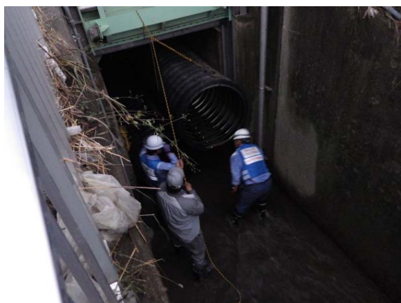
戸当り異物撤去 (飯富第二排水樋管)
