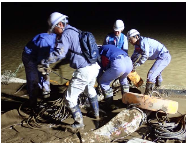
TEC-FORCEによるポンプの設置作業 (茨城県 水戸市)
