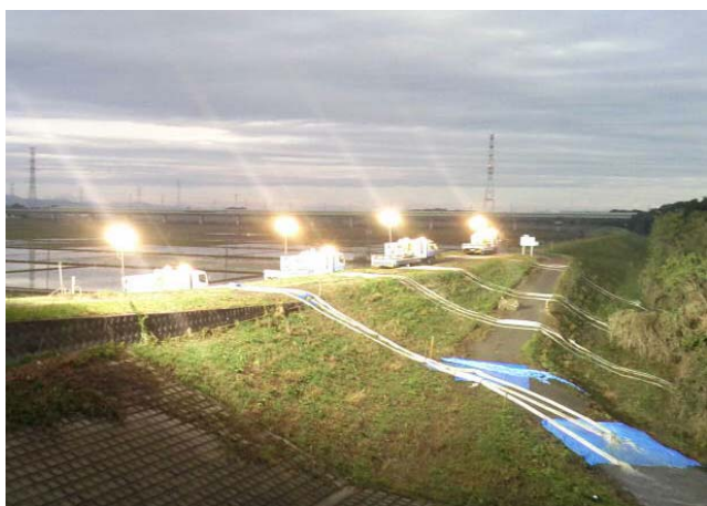
川島町要請の緊急排水活動 (埼玉県川島町 道場橋付近)
