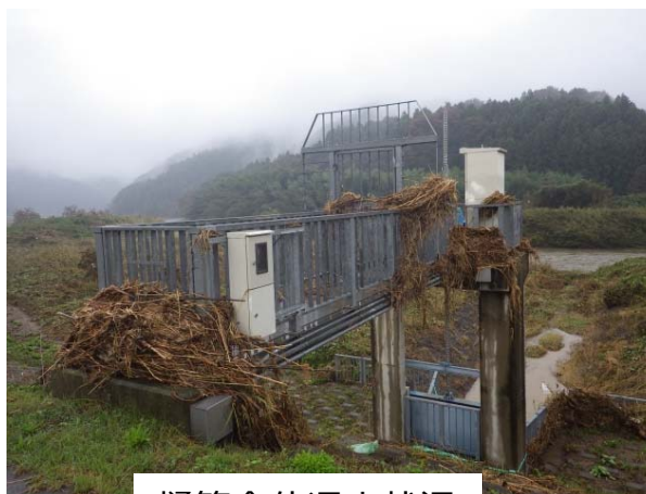
樋管全体浸水状況 (向田樋管)
