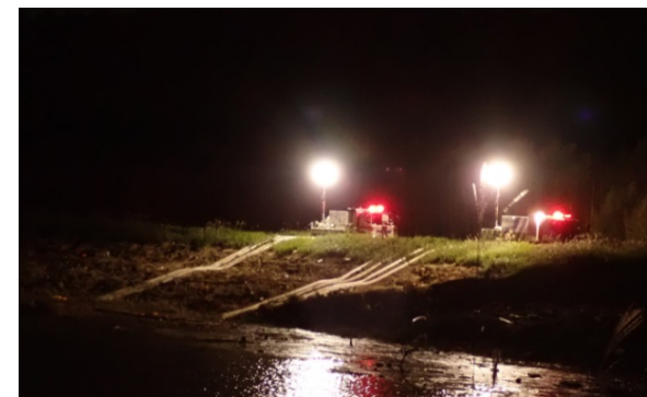
茨城県要請の緊急排水活動 (茨城県東茨城郡城里町神泉地先)
