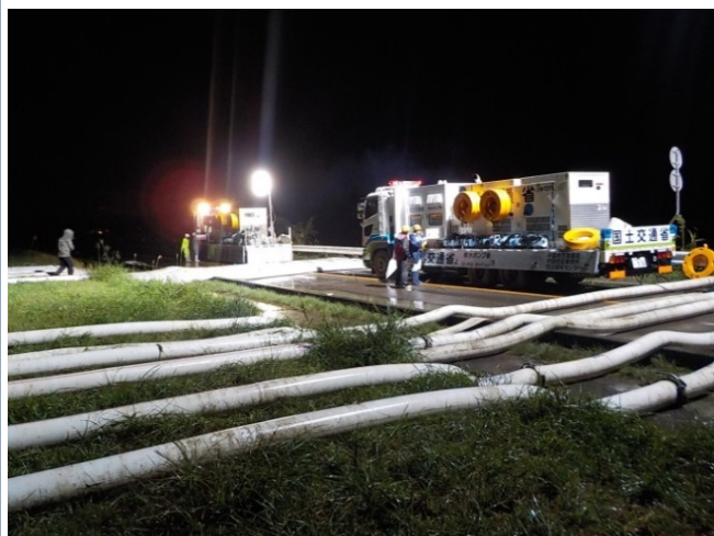
排水ポンプ車による夜間の緊急排水活動 (茨城県 水戸市)
