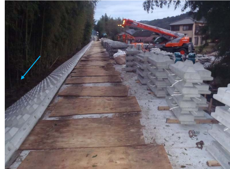
連節ブロック 施工中
