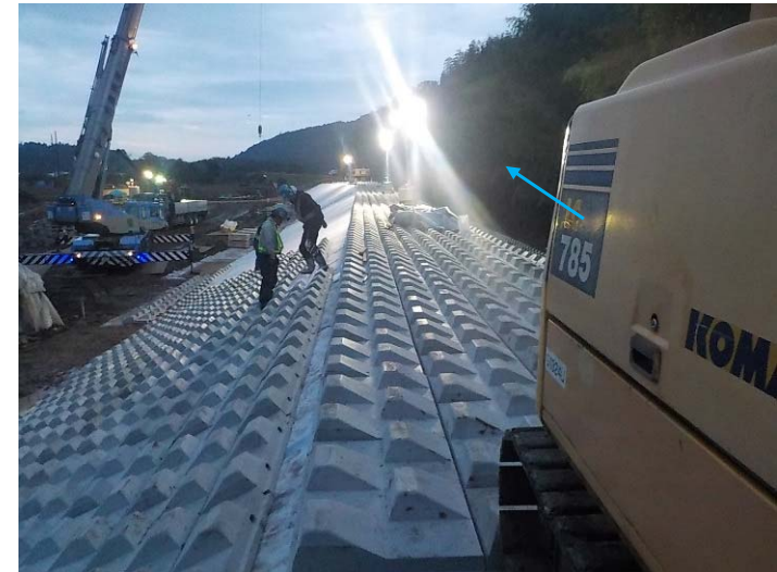
連節ブロック 施工中
