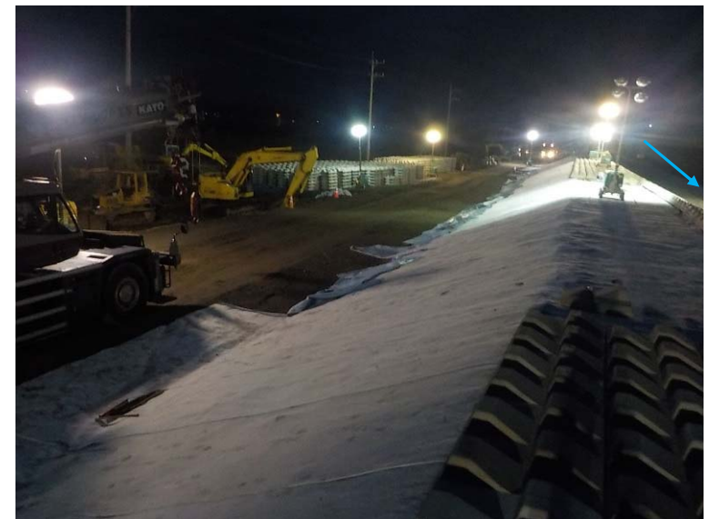
連節ブロック 施工中
