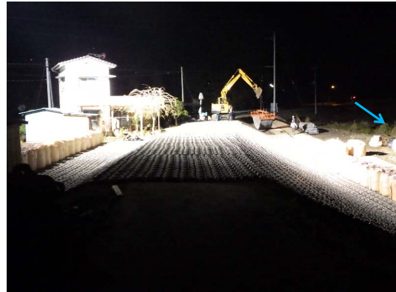
ブロックマット 施工中
