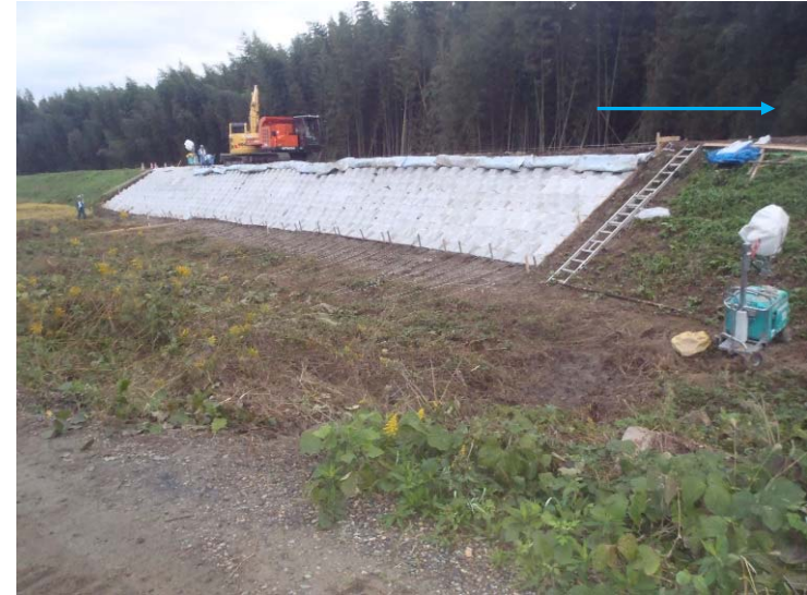
連節ブロック 施工中
