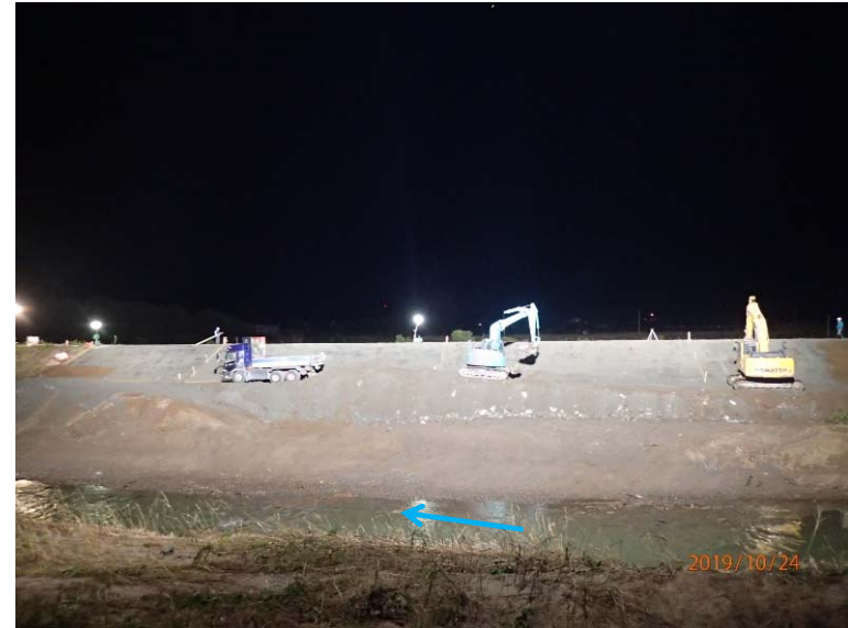
法面整形 施工中
