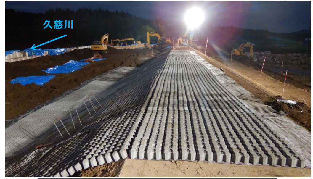
ブロックマット設置 施工中
