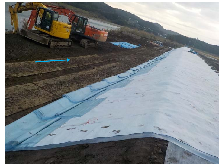
遮水シート張り 施工中
