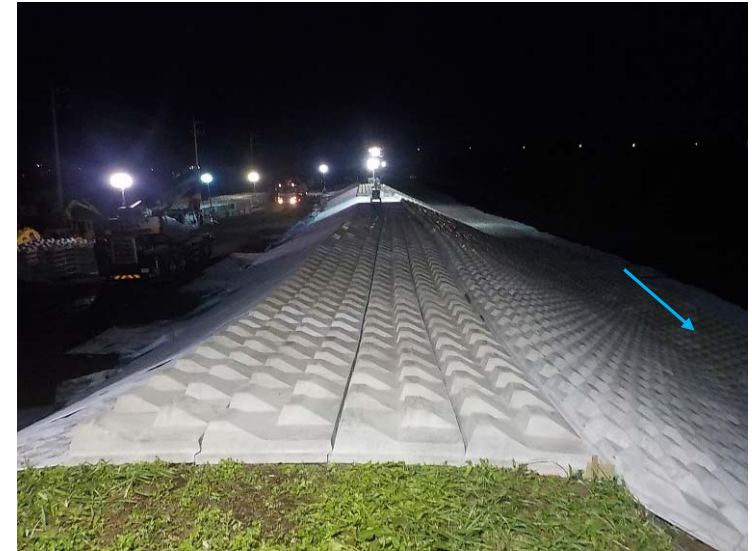
連節ブロック 施工中
