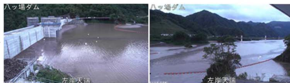
10月13日 6:00(EL.573.9m) 状況写真
