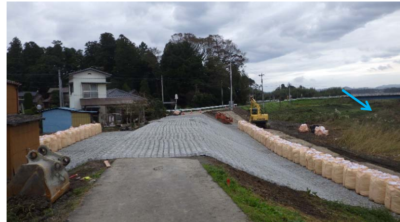
ブロックマット(アンカーピン) 施工中
