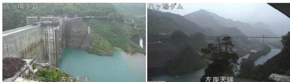
10月12日 9:00(EL.522.7m) 状況写真
