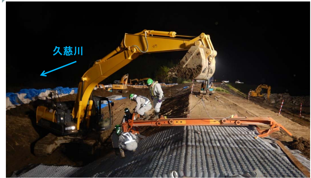
ブロックマット設置 施工中
