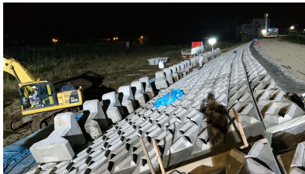
連節ブロック張 施工中
