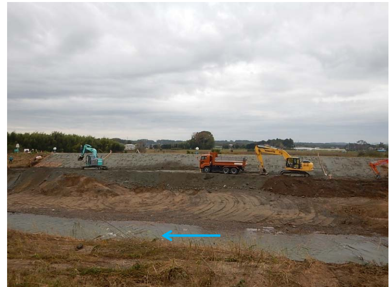
法面整形 施工中
