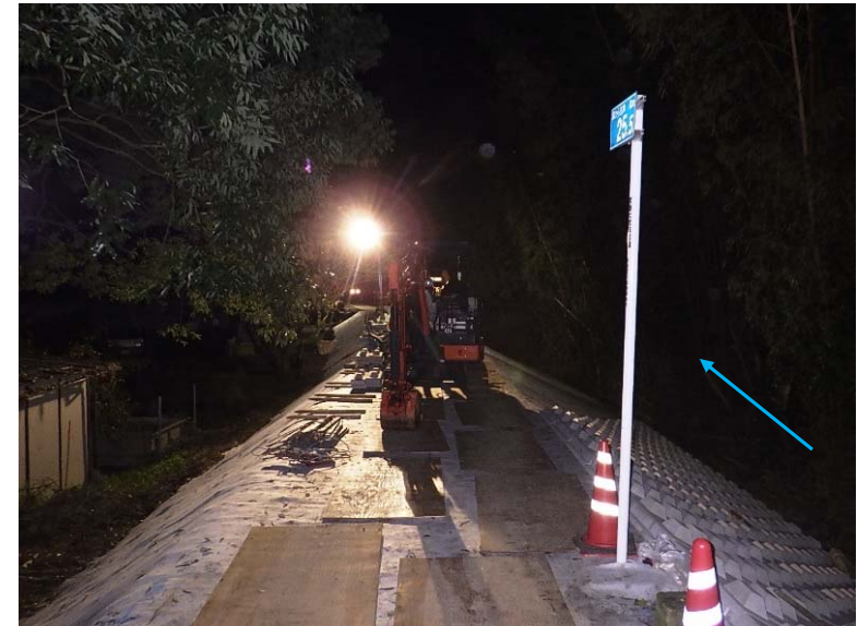
連節ブロック 施工中
