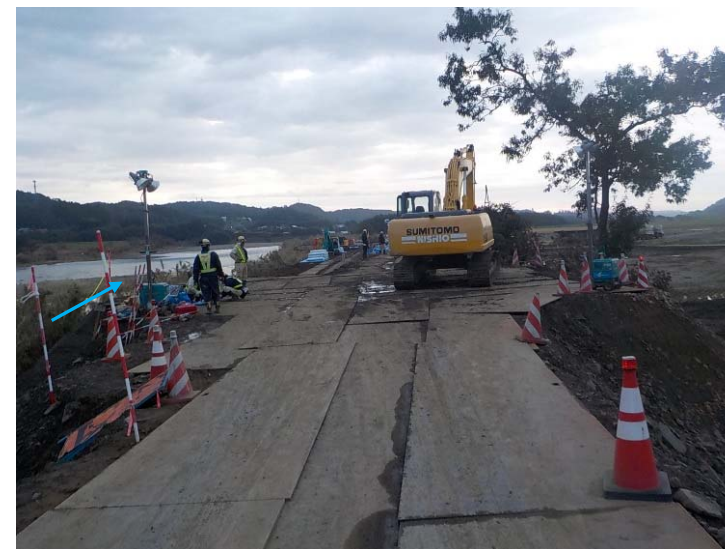
遮水シート張り 施工中
