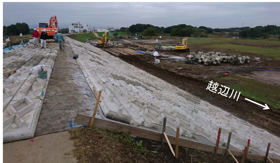
連節ブロック張 施工中
