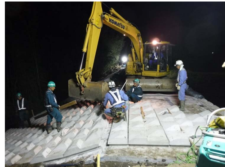
連節ブロック 施工中
