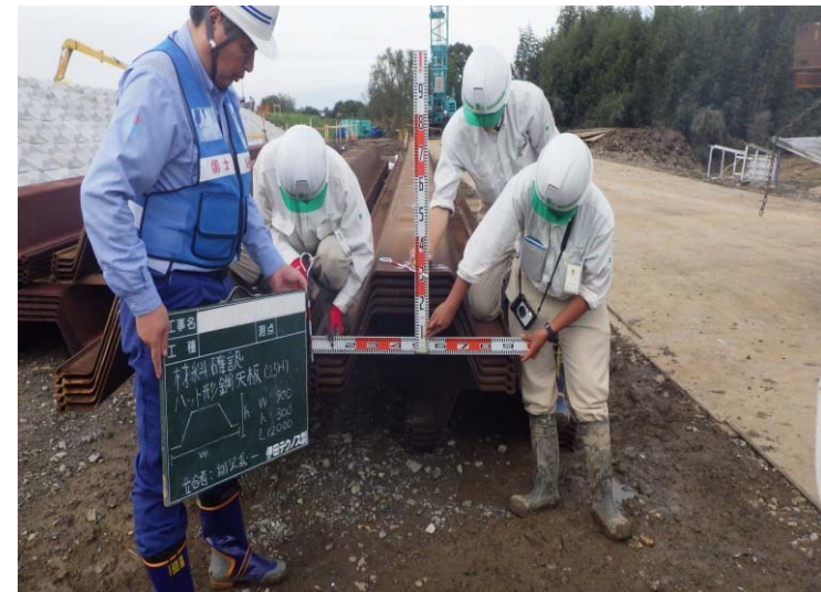
二重締切工の矢板材料確認中
