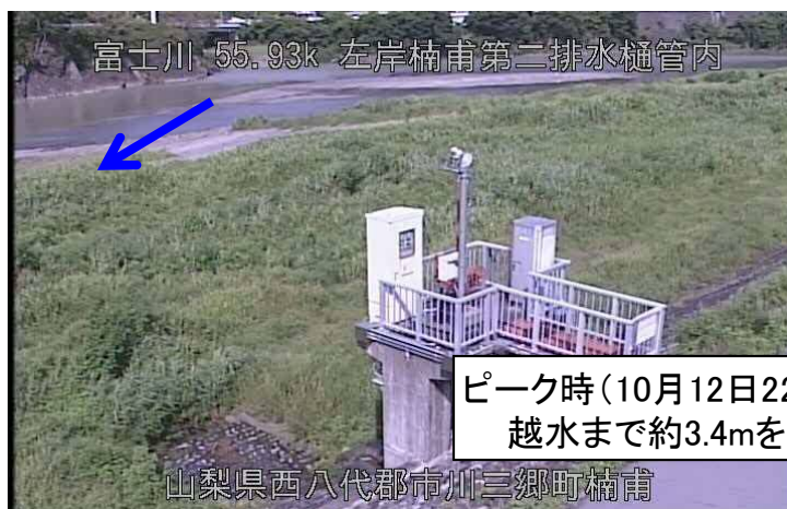
楠甫第二排水樋管内CCTV画像(平常時)
