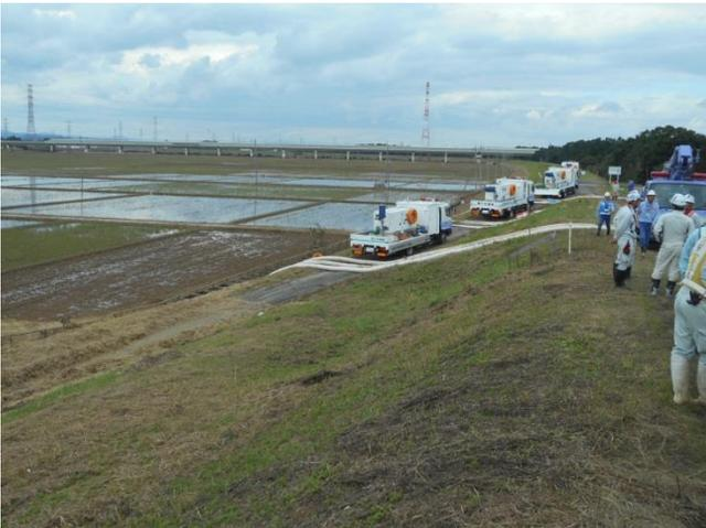
排水ポンプ車・照明車設置状況(10月15日午前)
