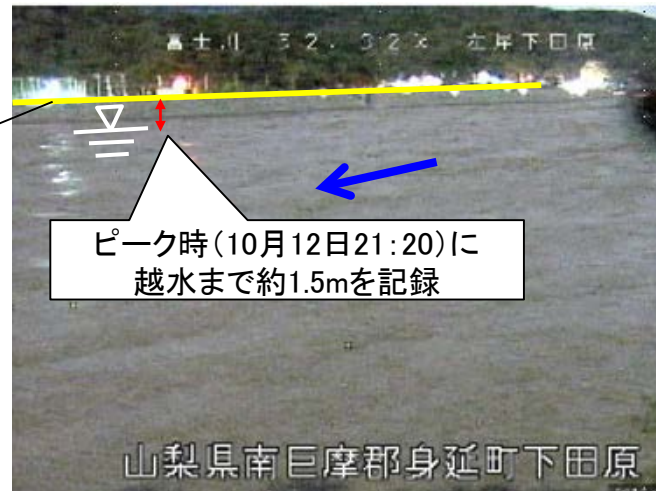
下田原CCTV画像(出水時)
