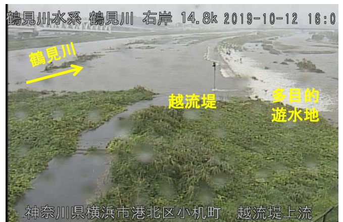
鶴見川:右岸 14.8k付近 多目的遊水地(越流堤)(横浜市港北区小机町地先)
