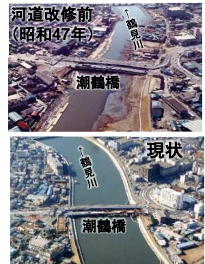
河道改修により、河道能力が大幅にアップ
