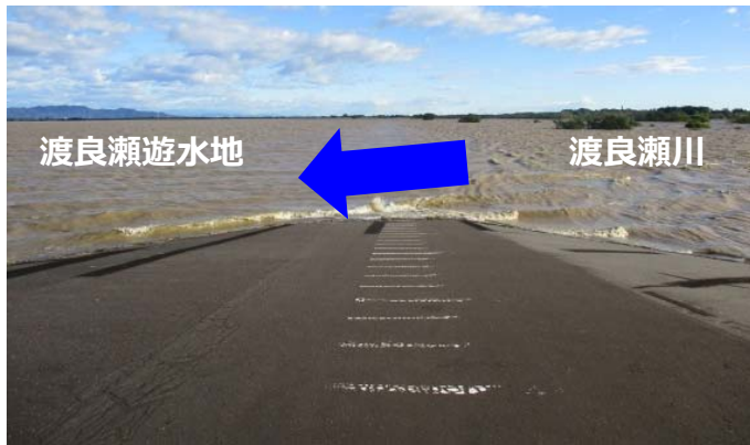
渡良瀬遊水地 第一越流堤（下流） 10月13日7時40分頃
