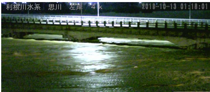
乙女水位観測所付近 (10月13日01時頃)
