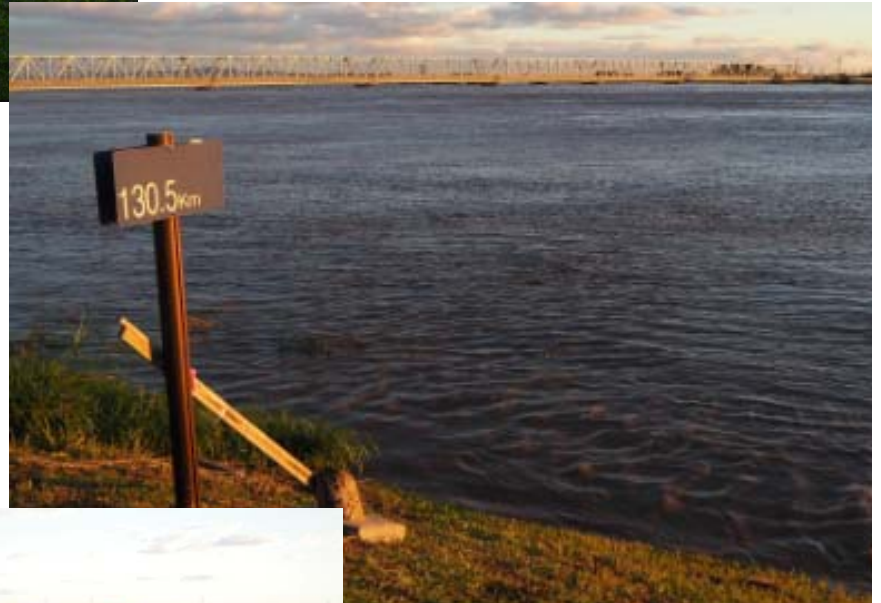
JR東北本線利根川橋梁付近 (10月13日05時頃)
