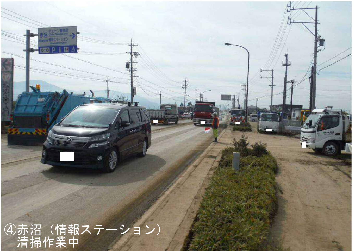
③津野 歩道部泥土処理作業中
