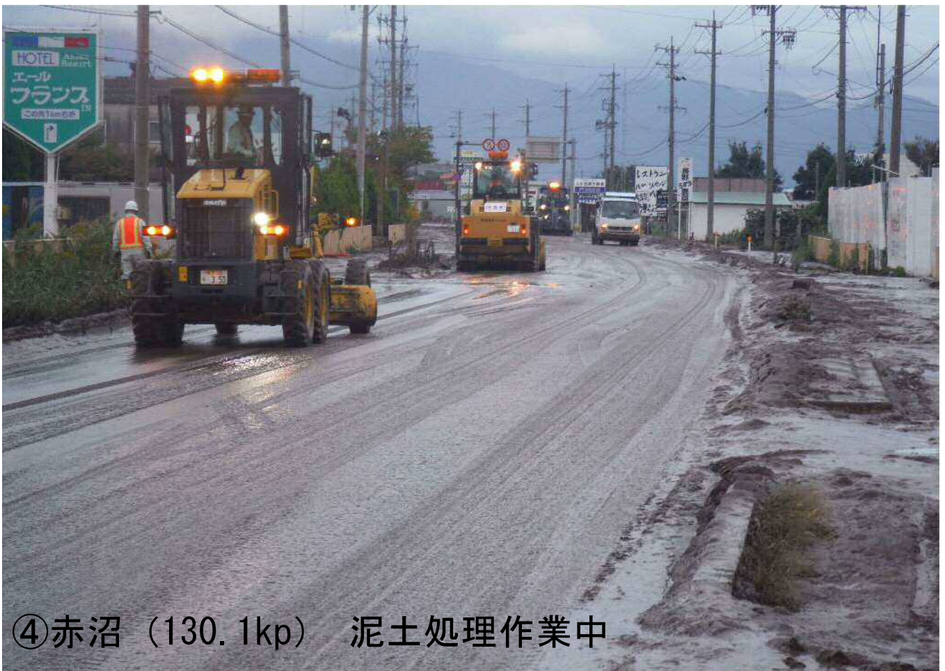
③津野 泥土処理作業中
