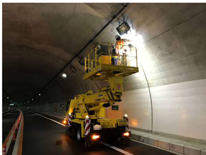
鴨狩津向トンネルの点検作業状況
