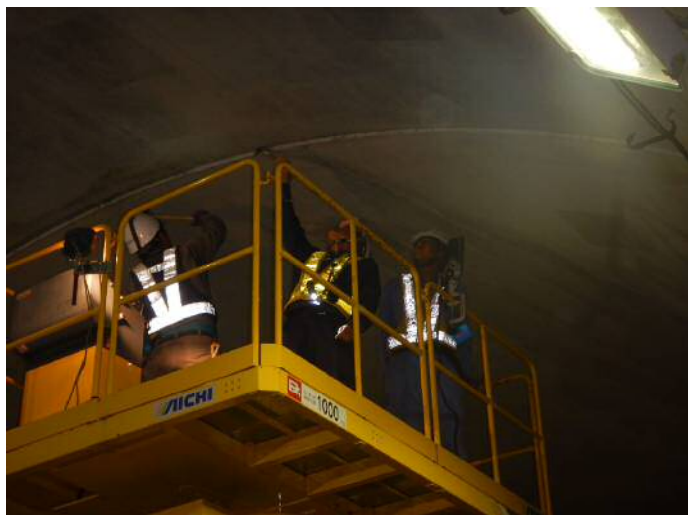
城山トンネルの点検作業状況
