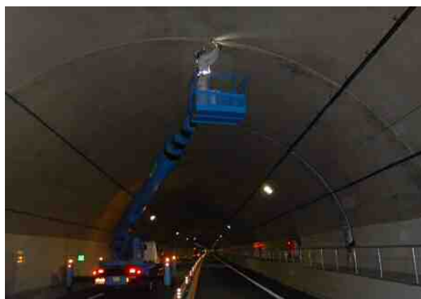
醍醐山トンネルの点検状況
