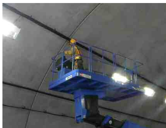
一色トンネルの点検状況
