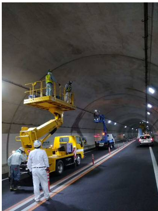
作業状況①
