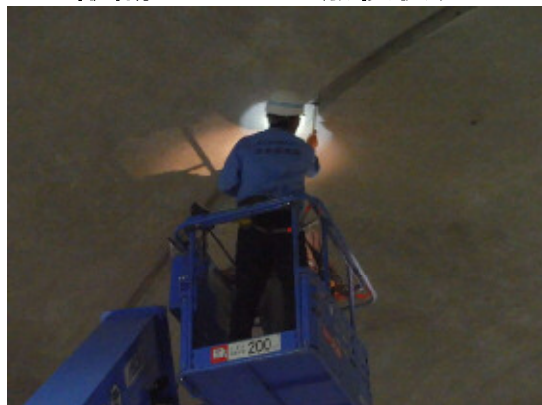
醍醐山トンネル点検状況
