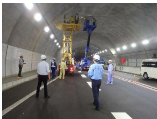
一色トンネル点検状況
