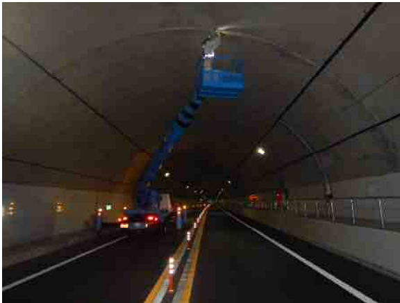
コンクリート打ち継ぎ目 (応急措置後)
