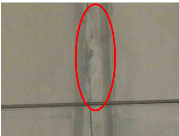
コンクリート打ち継ぎ目 (応急措置後)
