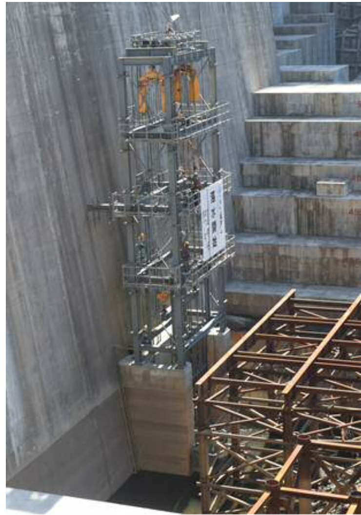
堤内排水路閉塞作業後(湛水開始)
