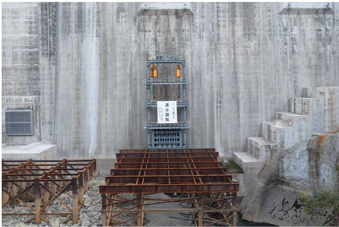
堤内排水路閉塞作業後(湛水開始)
