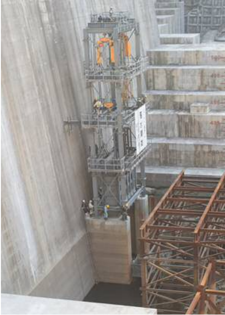
堤内排水路閉塞作業前
