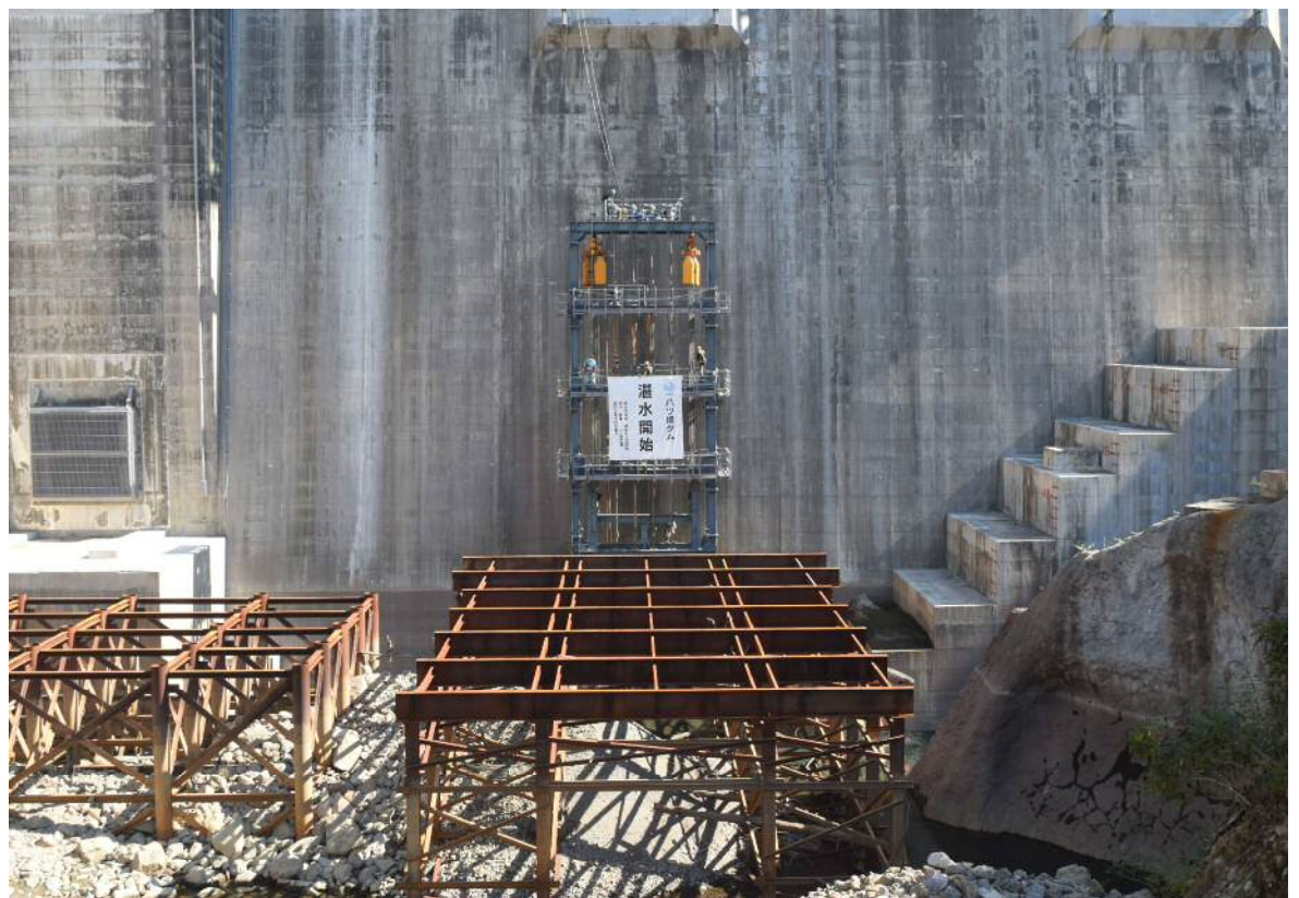
堤内排水路閉塞作業後(湛水開始)
