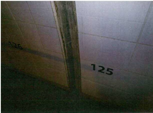
側壁の打継ぎ部
