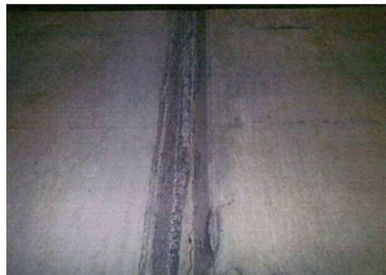
側壁の打継ぎ部
