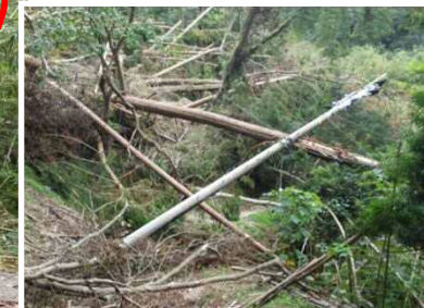
電柱の倒壊・倒木で通行止めとなっている道路
