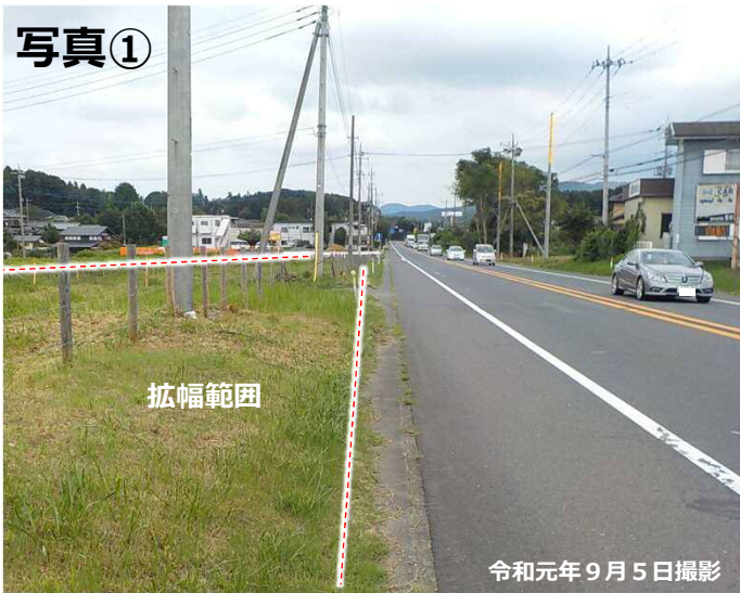
国道50号（水戸方面を望む）
