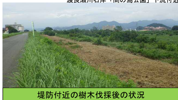
渡良瀬川右岸「間の島公園」下流付近
