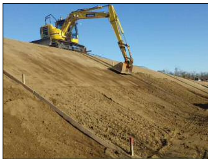
施工状況（法面整形）
