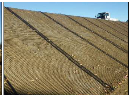
施工状況（補強シート敷設）
