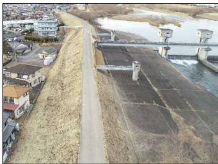
完成後の状況
