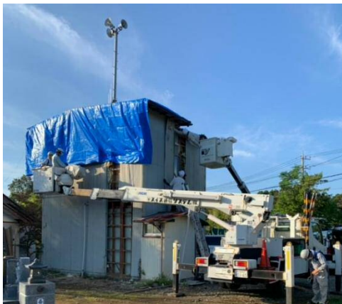
【ブルーシート作業状況(佐倉市)】
