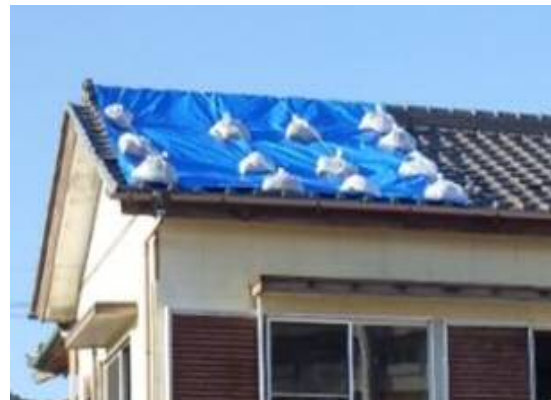
【ブルーシート設置状況(南房総市)】
