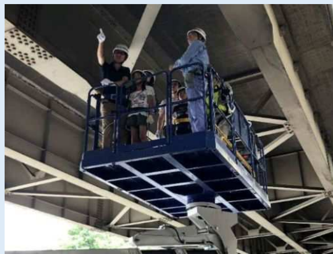
リフト車で橋梁点検体験
