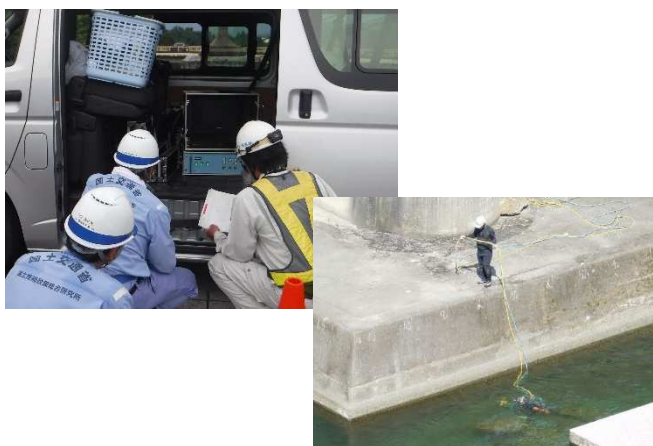
潜水土による洗掘調査の状況
