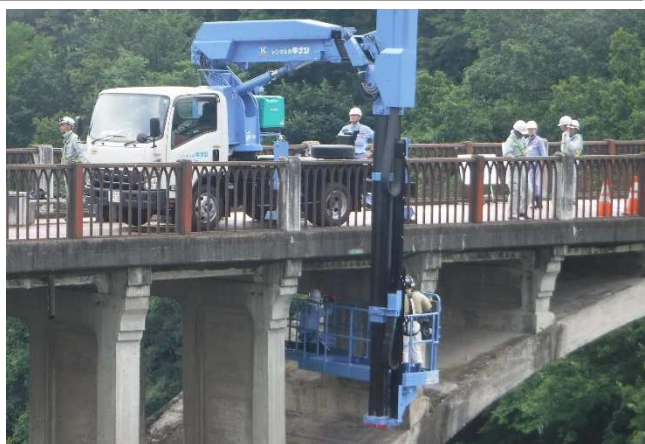
橋梁点検車を用いた近接目視の状況
