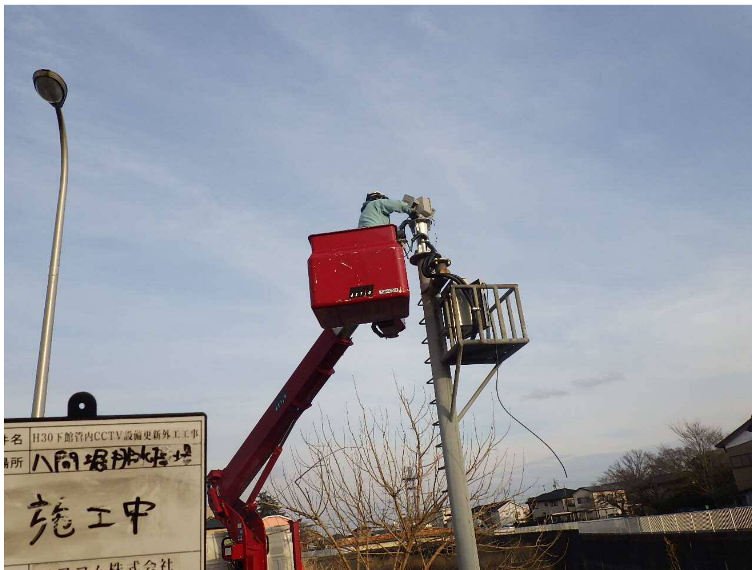
CCTV設備施工状況
