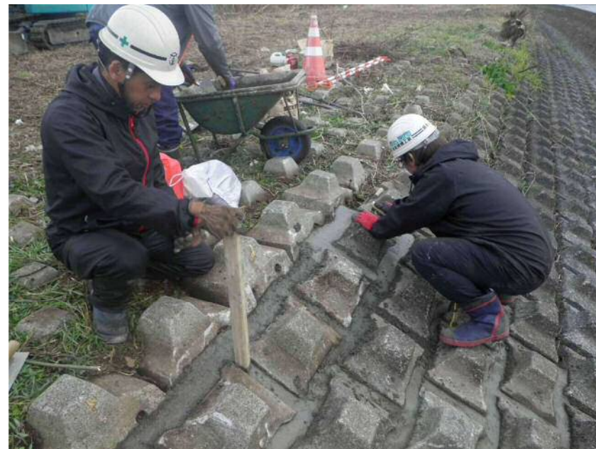
低水護岸補修
