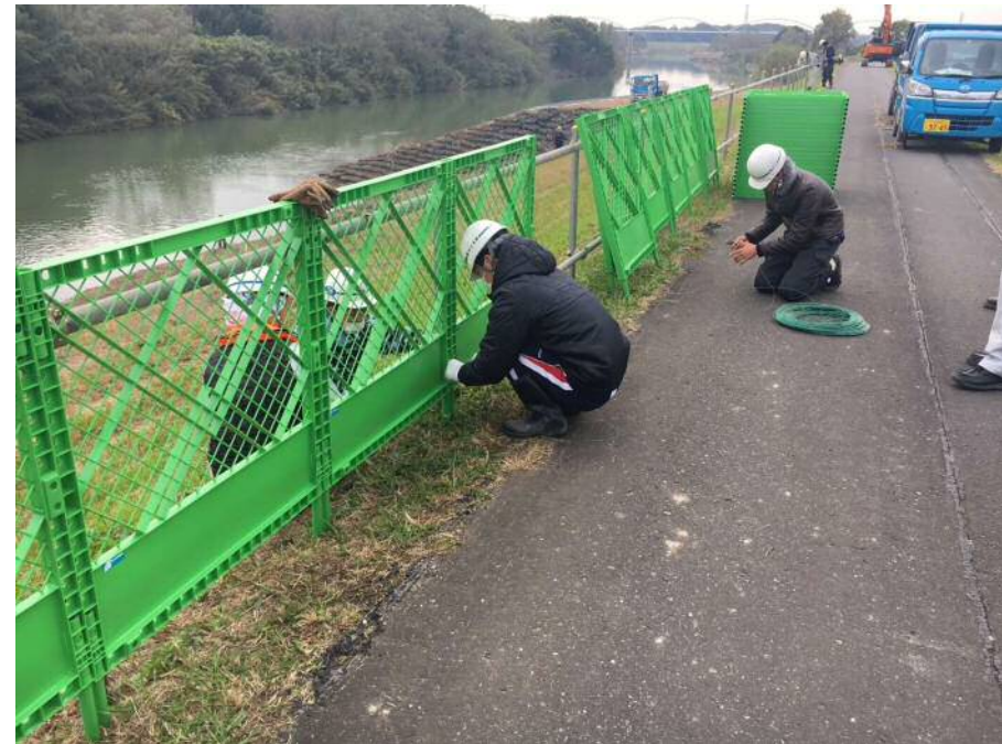
進入防止柵設置
