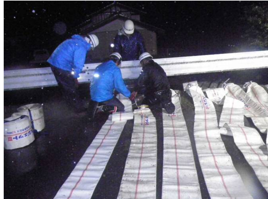
救急排水ポンプ作業
