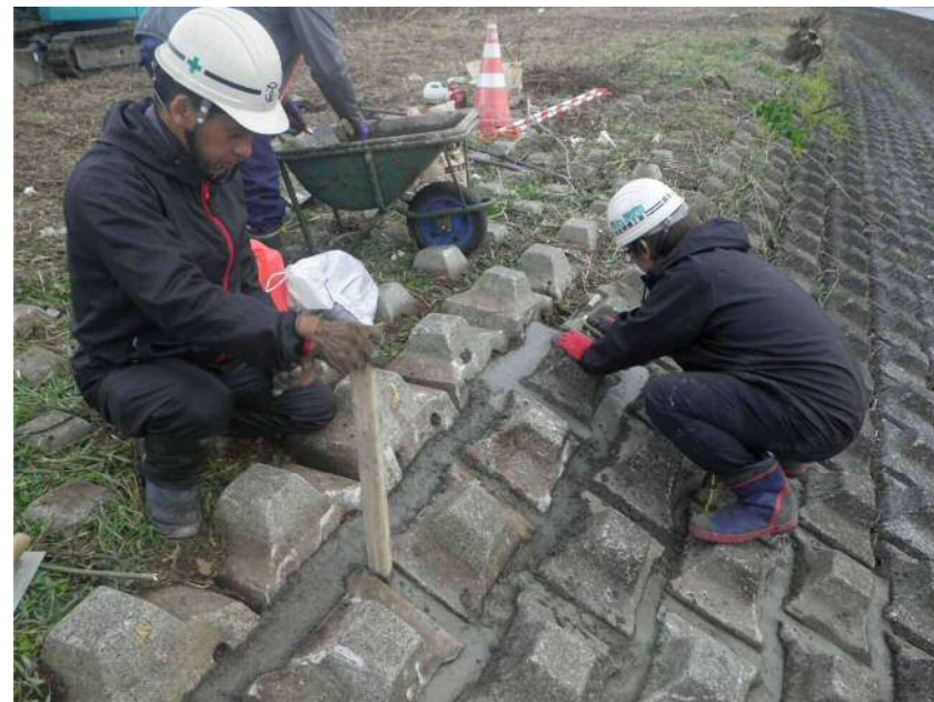
低水護岸補修
