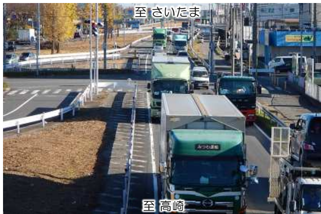
[熊谷スポーツ文化公園入口交差点付近（工事着手前）]
