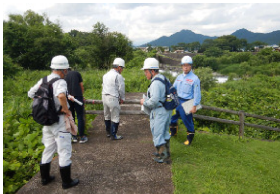
大谷川床固群の転落防止柵の点検
