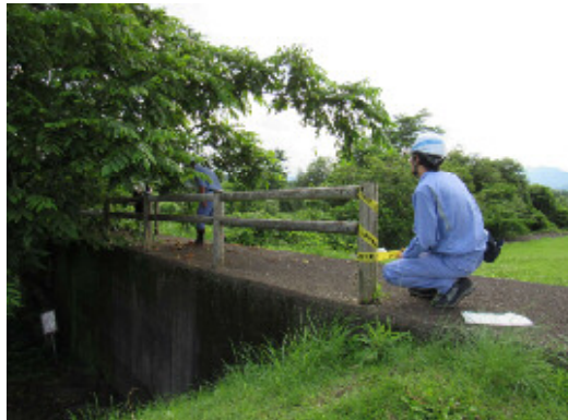
老朽化した転落防止柵に 注意喚起テープを貼りました
