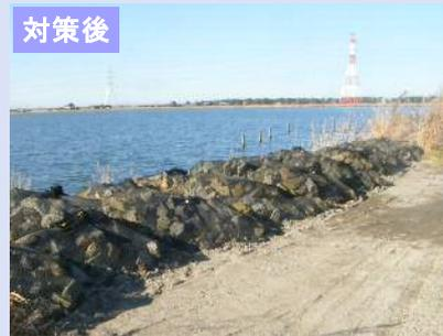
護岸に隙間があると、洪水や波浪時に水が入り込み、護岸や堤防が崩れるおそれがあるため、袋詰め根固めを応急的に設置しました
