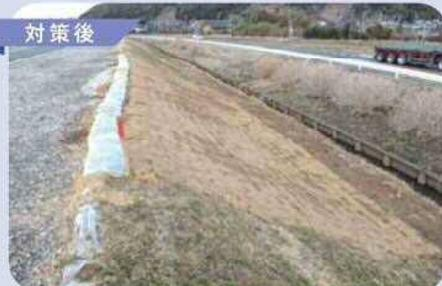
堤防に穴が空いていると、堤防が雨水で削られて弱くなってしまいますため、穴をふさぎ補修しました
