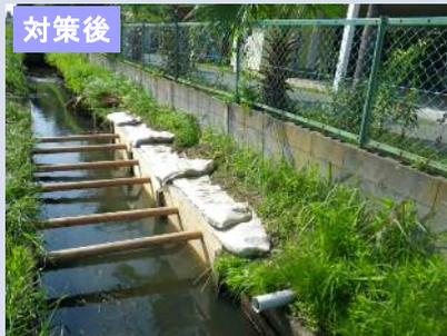
水路に土砂や植生があると水の流れのジャマになるために、水路の土砂と植生を撤去しました
