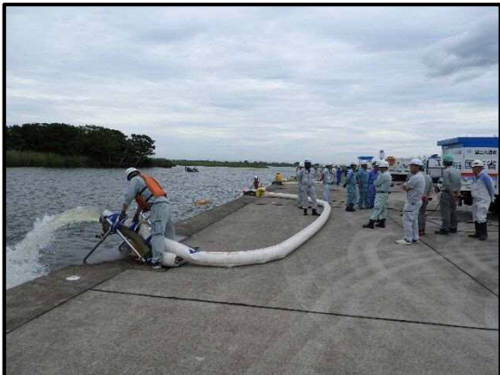
・排水ポンプ車 台風などの大雨にともなう洪水対策として、排水作業を迅速かつ効率的に実施します。本講習では、ポンプの組み立てから排水までの作業を行いました。
