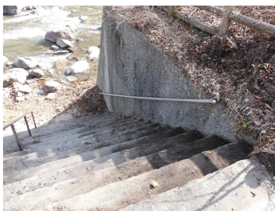
堆積している土砂を撤去
