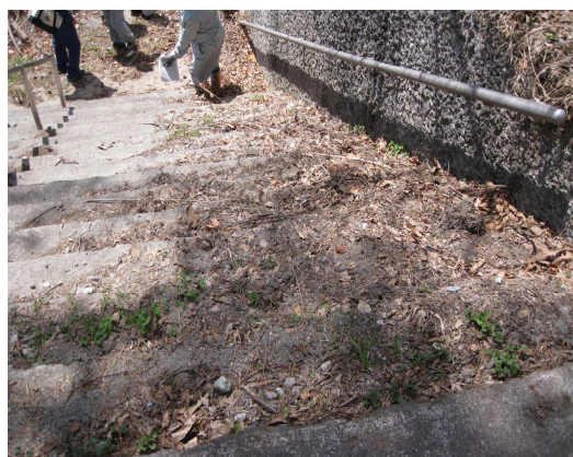
階段に土砂が堆積している
