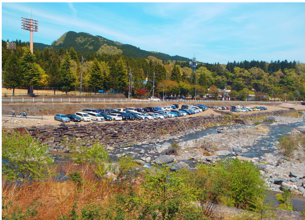
大谷川床固工部の臨時駐車場状況
