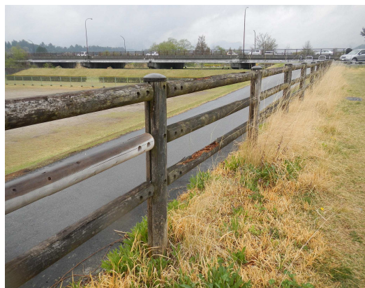
転落防止柵の老朽化
