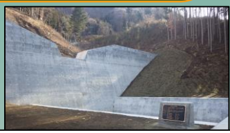
H29柿平沢砂防堰堤工事
