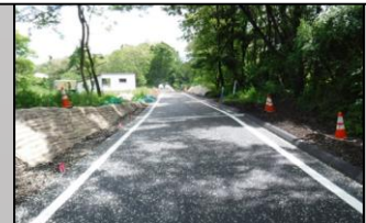
H29浅間南山麓工事用道路工事
