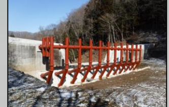
H30片品川流域砂防整備工事
