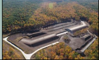
H29濁沢第二砂防堰堤(本堤)工事
