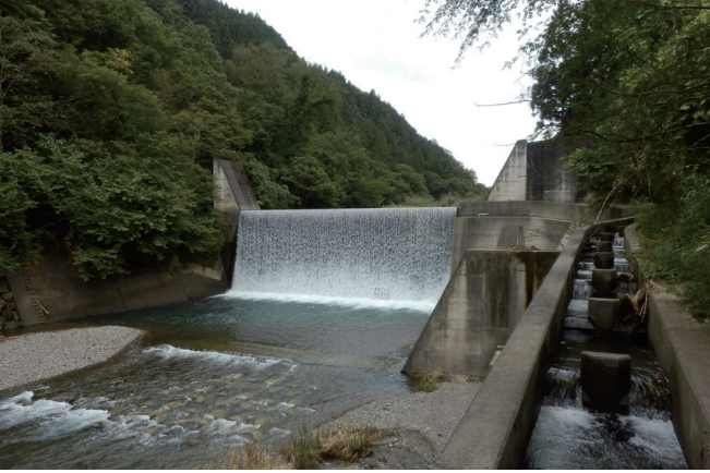
乙母砂防堰堤（不透過型）
