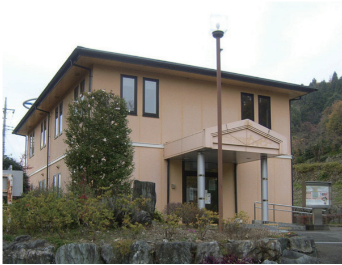
讓原防災センター
