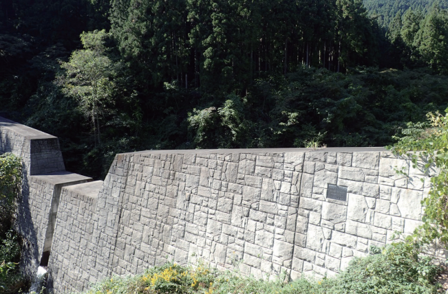
大沢第二砂防堰堤（透過型：コンクリートスリット）
