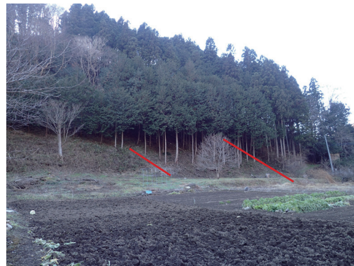
崩れたところの現在の様子
