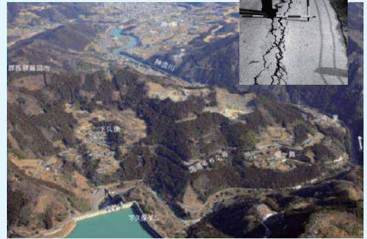
譲原地すべり地区の様子
