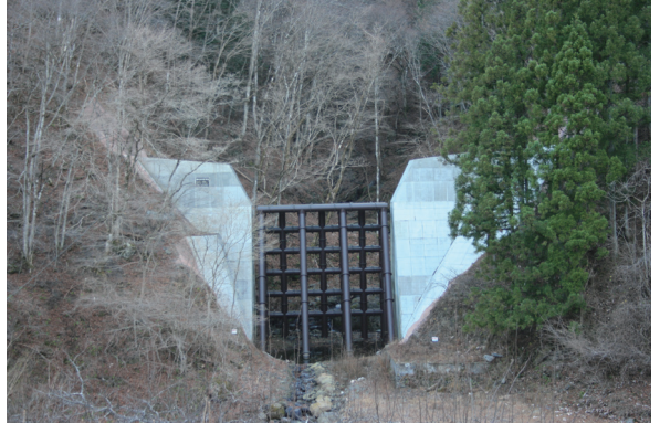
滝の沢砂防堰堤（透過型：鋼製スリット）
