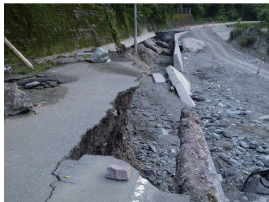
神流町船子川の道路の被害
