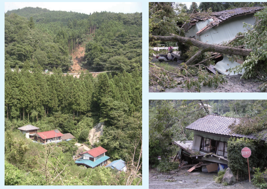
平成19（2007）年の藤岡市坂原（左写真）、藤岡市保美濃山（右写真）のがけ崩れの様子
