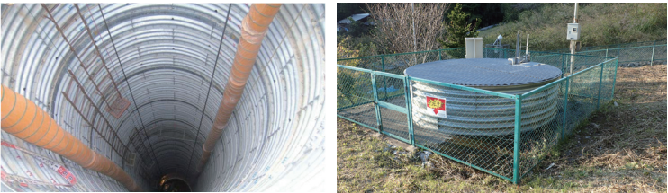
地下水を集める井戸（集水井）
