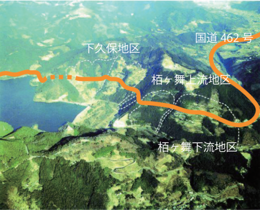
譲原地すべり防止区域 点線で示したところが地すべりのブロック（かたまり）です。
