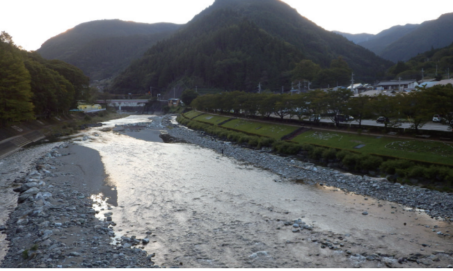
護岸工（神流町こいこい橋より川上の様子）
