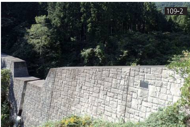
おおさわだいに 大沢第二砂防堰堤（透過型：コンクリートスリット）
