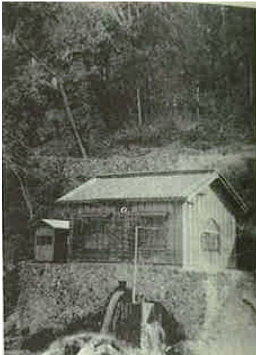
むかし こだいら 小平 そんえい にあった神川村営電気の水力発電所
