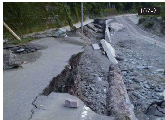
神流町船子川の道路の被害
