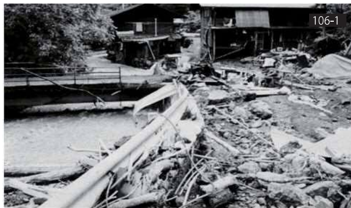
上野村所ノ沢の被害
