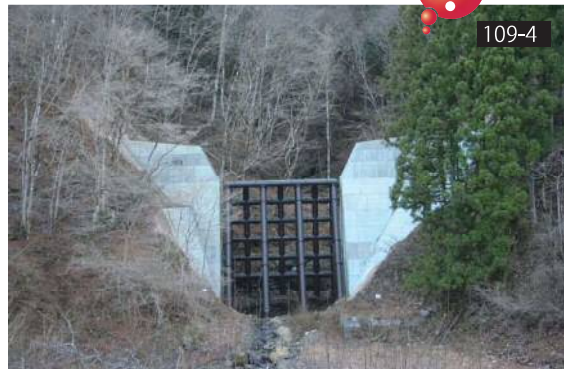
たき さわ 滝の沢砂防堰堤（透過型：鋼製スリット）
