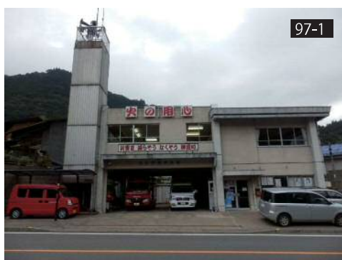
くるだ 神流町黒田にある奥多野消防分署
