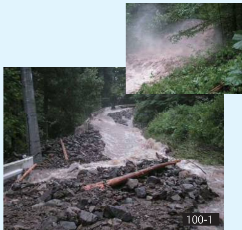
平成19(2007)年の塩沢川の土砂流出のようす
