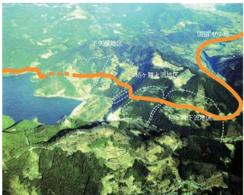
譲原地すべり地区の全体の様子（藤岡市譲原）
