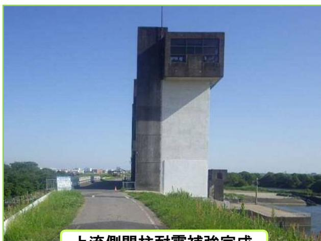
上流側門柱耐震補強完成
