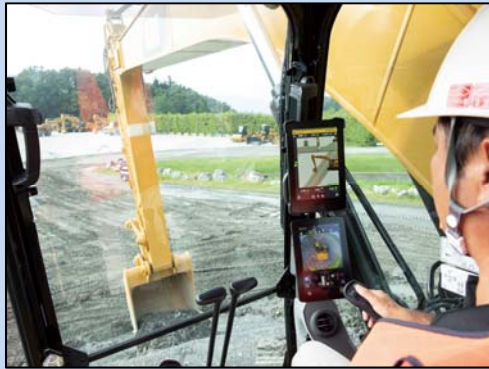
最新マシンコントロール技術の紹介
