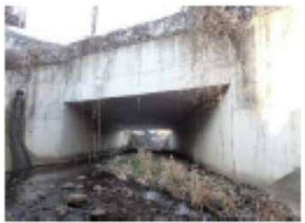
▲水路ボックス
