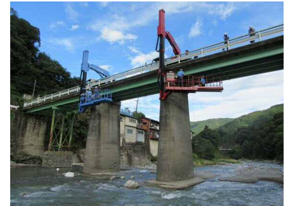
御銚橋（群馬県）における直轄診断(H28)
