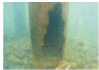
▲橋脚水中部の断面欠損
