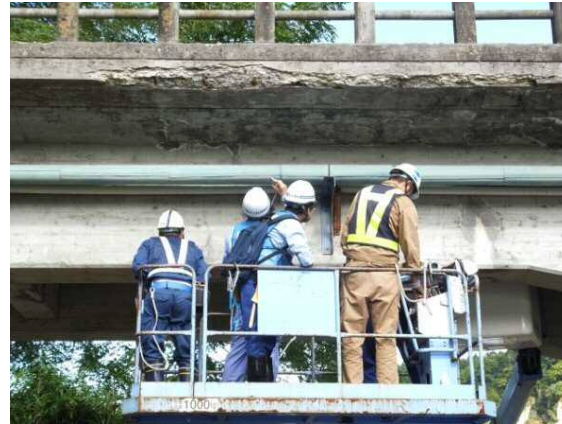
大前橋（群馬県）における直轄診断(H26)
