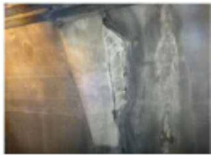
▲トンネル目地部
