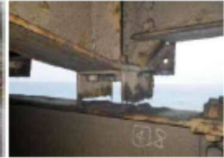
▲シェッド主梁端部破断
