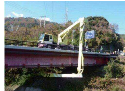
橋梁点検車による点検状況
