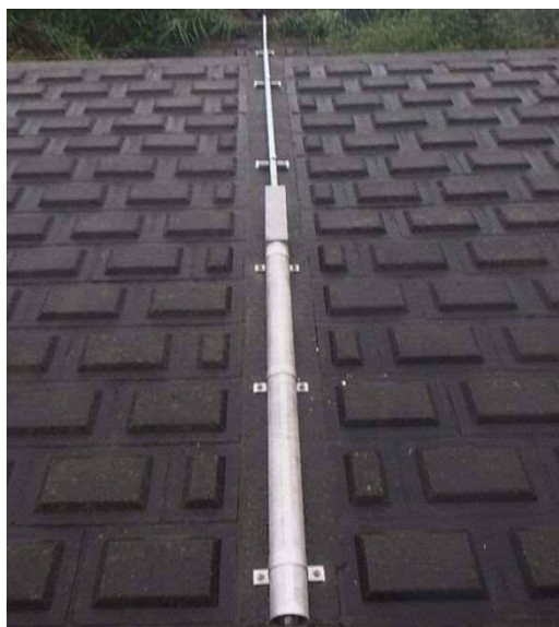
簡易水位計 設置状況 水晶式センサー
