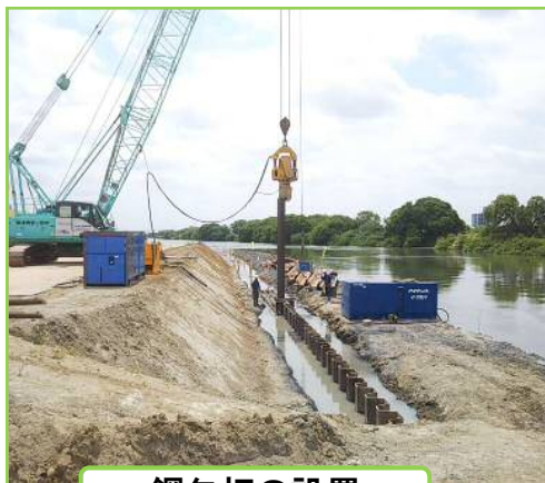
鋼矢板の設置
