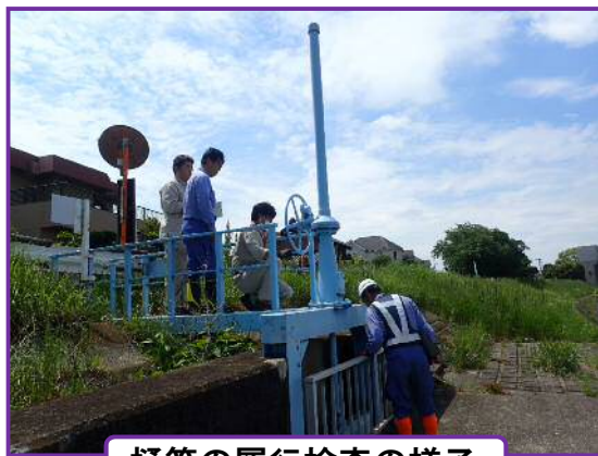
樋管の履行検査の様子
