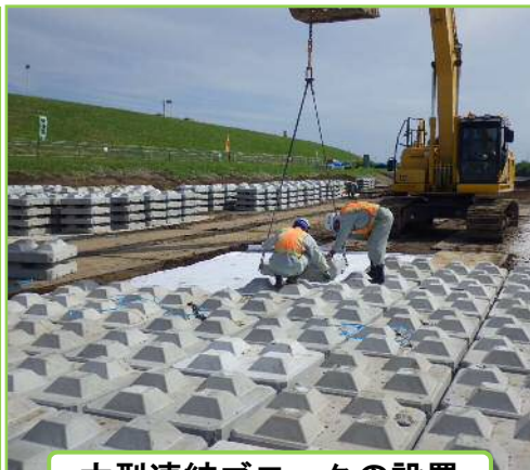
大型連結ブロックの設置
