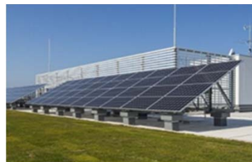
屋上緑化・太陽光パネル
