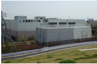
雨水ポンプ場 【H29年度供用開始】 (千葉県市川市)
