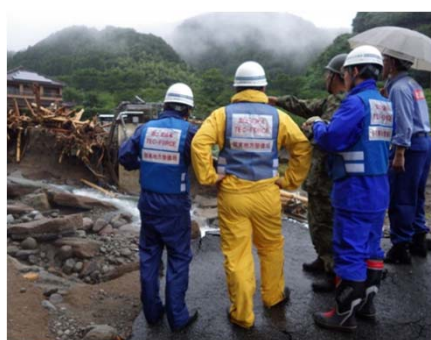
応急復旧のための現地調査
