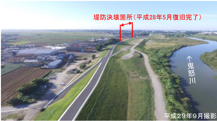
堤防決壊箇所付近(常総市新石下地区～上三坂地区、21.0km付近)
