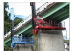
↑ 上部工の損傷状況調査
