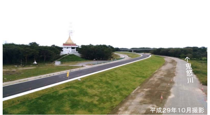
溢水箇所付近(常総市若宮戸地区、25.0km付近)
