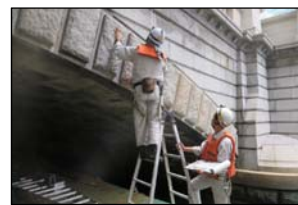
近接目視による橋梁点検
