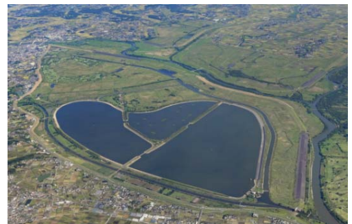
渡良瀬遊水地は豊かな自然環境からラムサール条約湿地に登録されており、掘削とあわせた湿地の保全・再生を行っています。
