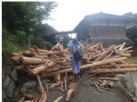
道路被害状況の調査
