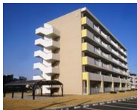
公営住宅整備事業 (茨城県)
