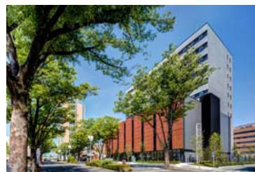
前橋地方合同庁舎
