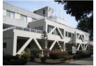
総合運動公園事務所 (栃木県)
