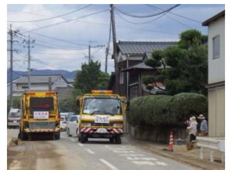
粉じん防止のための散水作業
