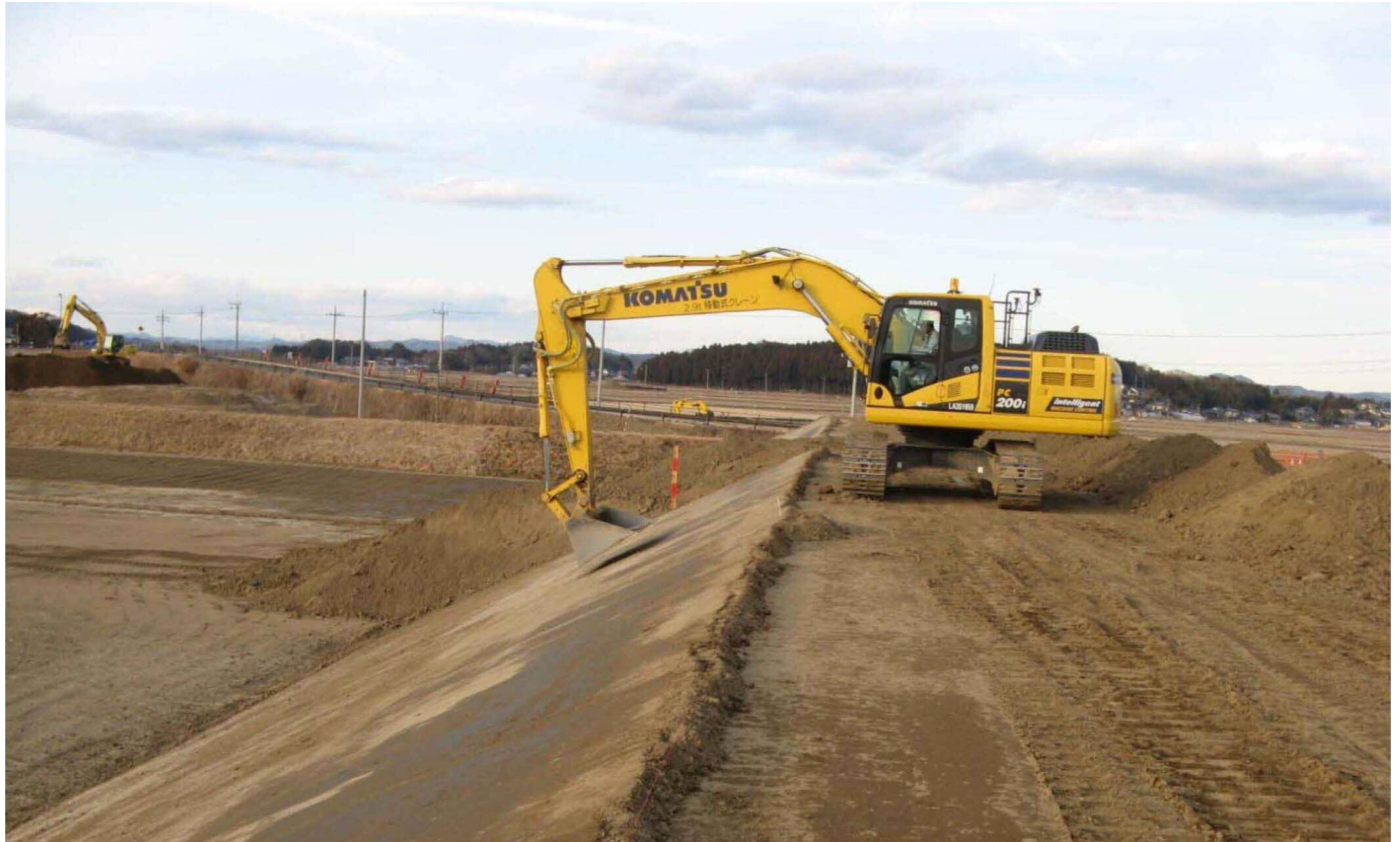
作品タイトル：土で出来た滑り台 撮影者コメント：バックホウによる法面整形 撮影日・撮影場所：2018/11/30 茨城県常陸太田市小島町地先 撮影者会社名：長山工業(株) 撮影者：仁瓶 貴之
