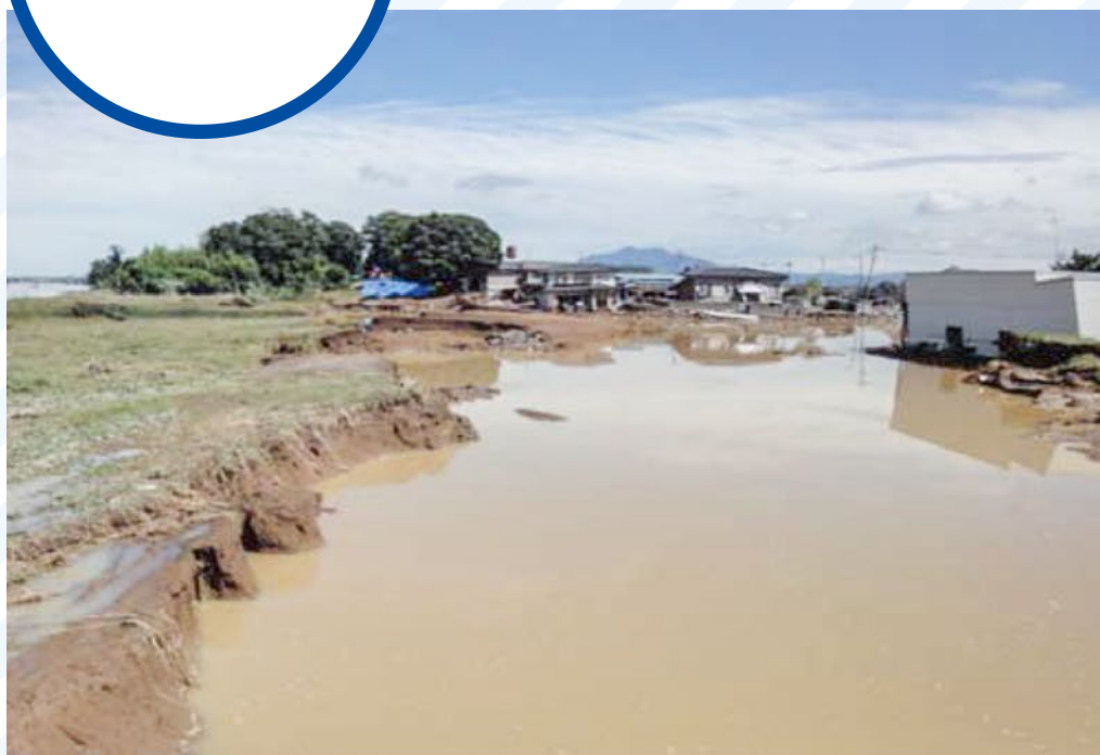
【施工前】2015年9月11日
