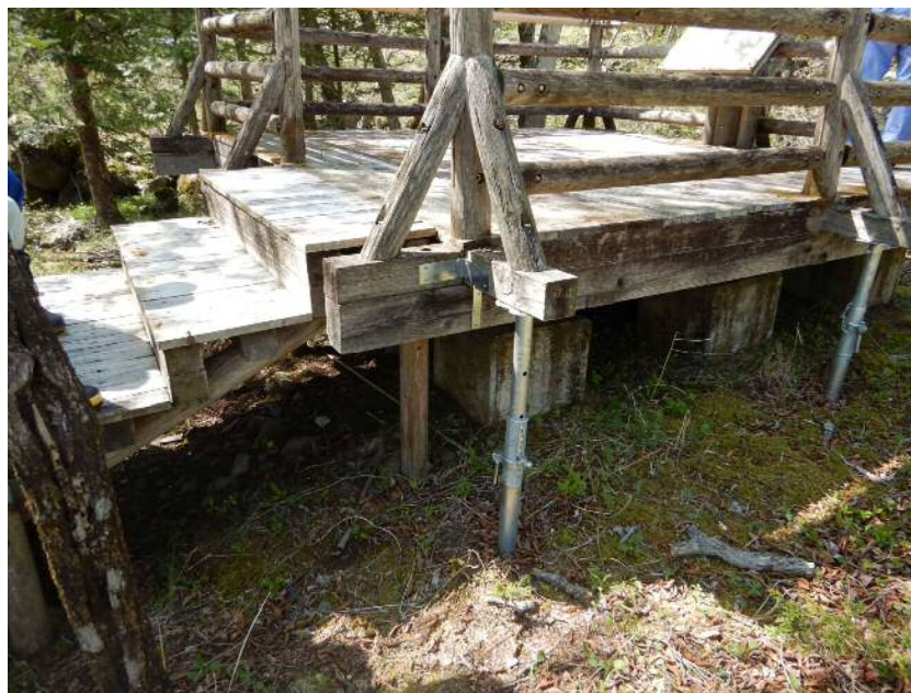
展望台の転落防止柵のぐらつき
