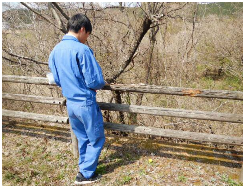
転落防止柵老朽化
