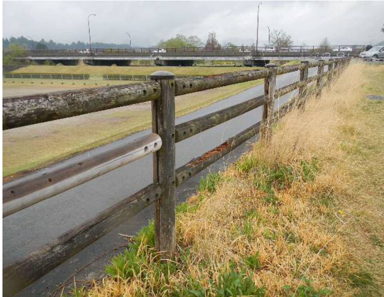
転落防止柵老朽化
