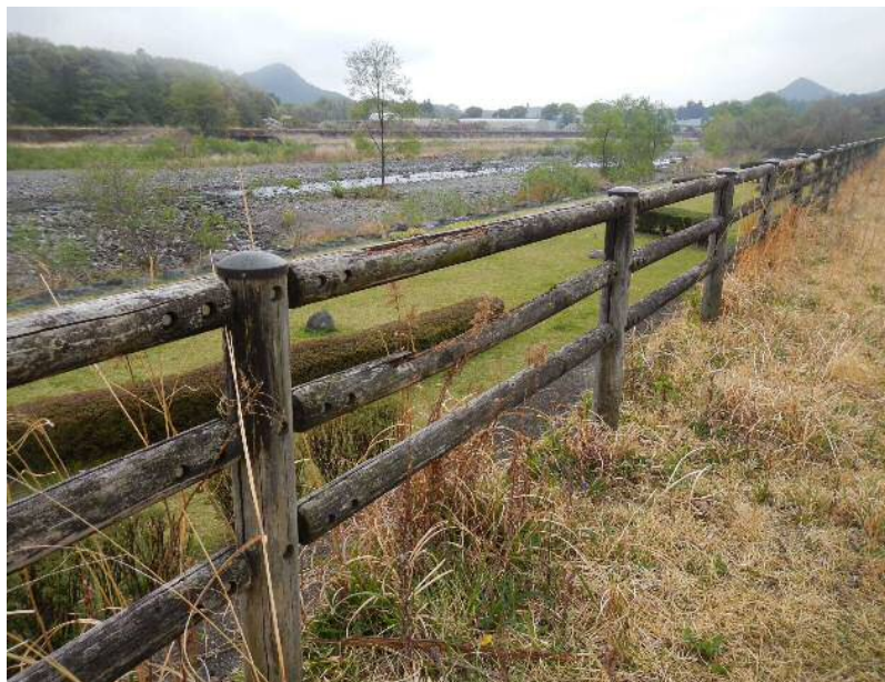
転落防止柵老朽化
