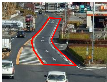
【速度抑制対策】減速路面標示 矢板市
