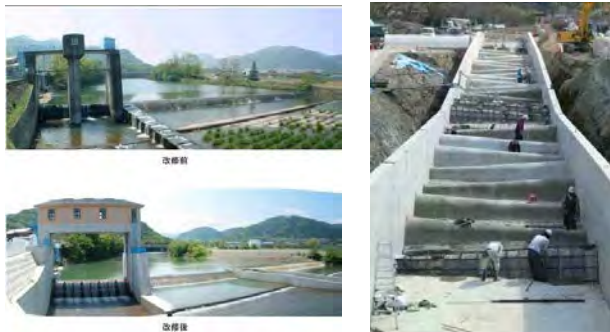
改修前後の神流川頭首工（左）と、魚道（ハーフコーン型）設置の様子（右） （出典：関東農政局 HP）
