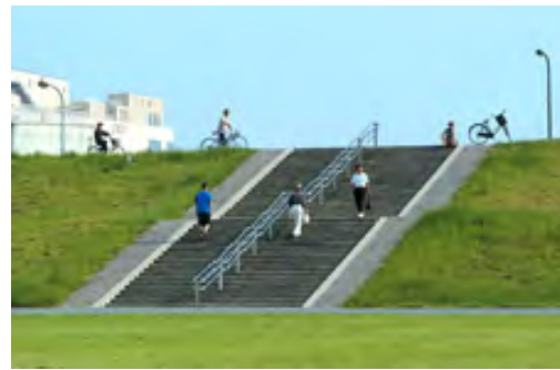
高齢者や子どもにも便利な 二段式手すり付きの階段 （出典：国土交通省荒川下流河川事務所 HP）
