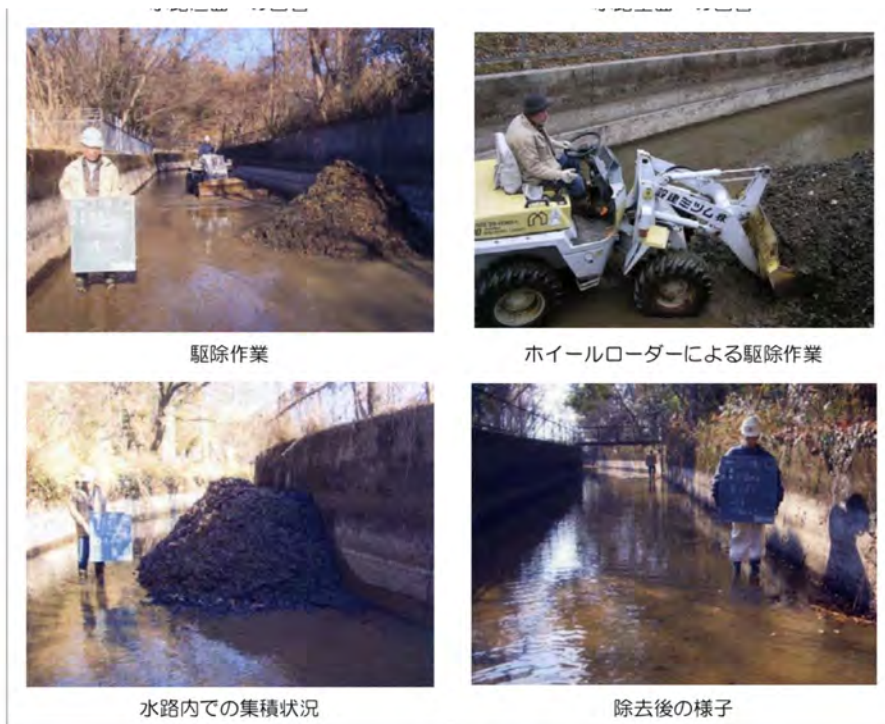
図 63 幹線水路（開水路）で重機を用いた除去の事例
