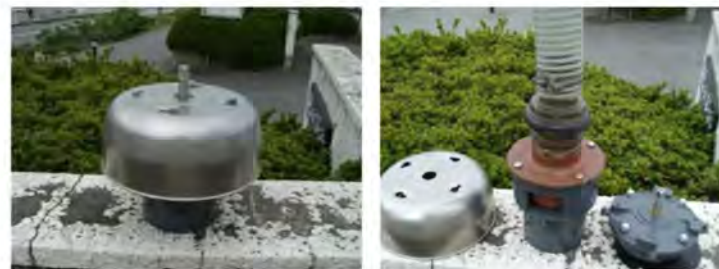
図 65 一筆用給水栓（写真左）一筆用給水栓への接続状況（写真右）
