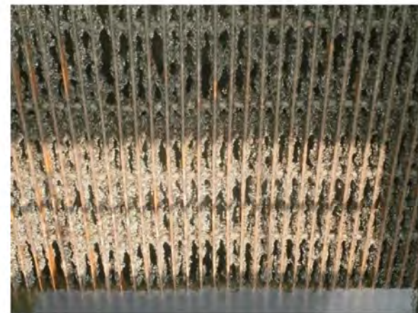
写真-2 スクリーンへの付着状況
