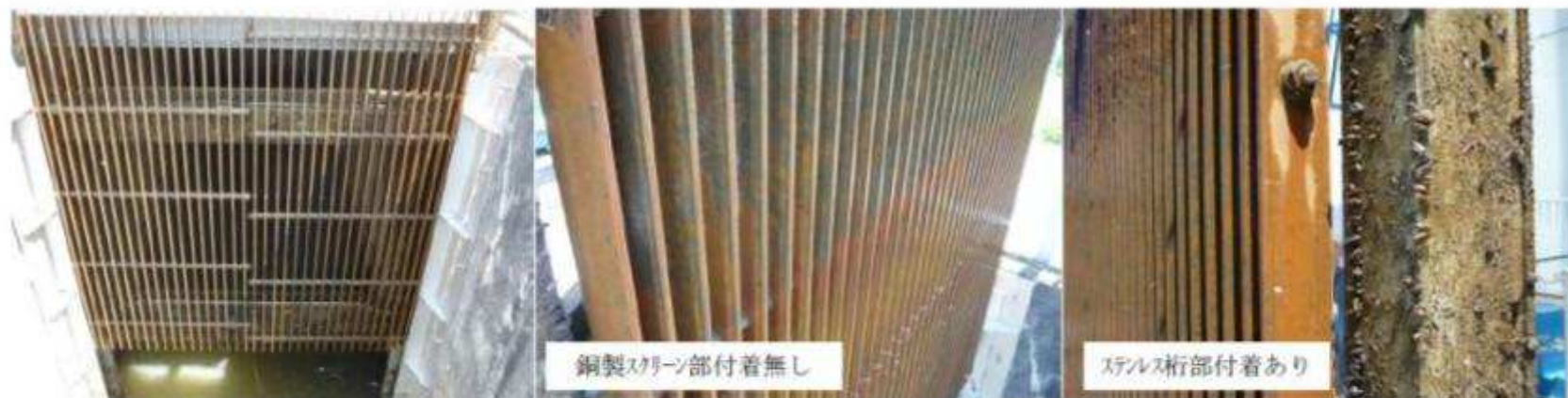
設置一年目の状況(平成29年7月31日)
