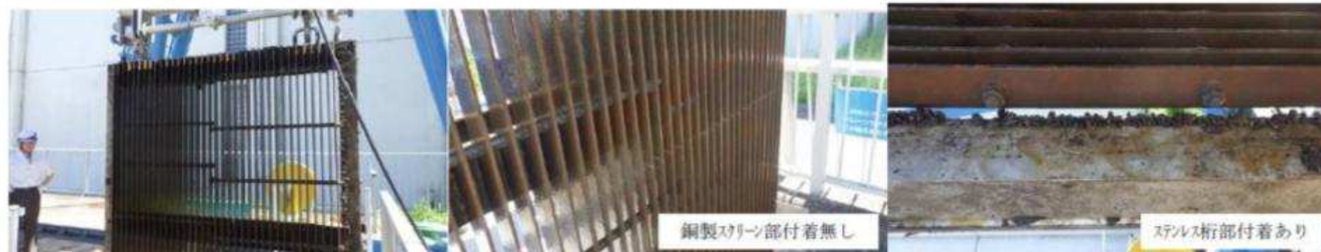
設置二年目の状況(平成30年7月31日)
