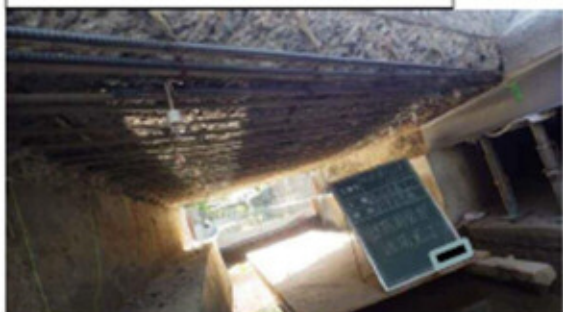
コンクリート脆弱部の除去
