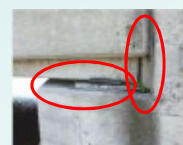
支保交換や桁端点検の空間なし
