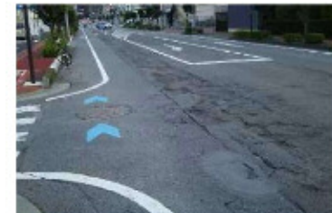
占用工事が起因する路面損傷
