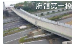
ロッキング橋脚を有する橋の落橋
