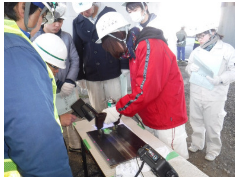
鋼部材の疲労亀裂の詳細調査
