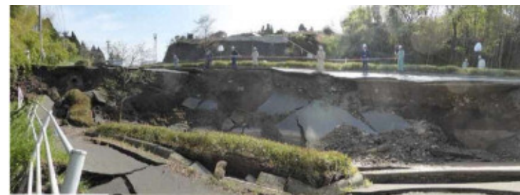
路面陥没地付近の状況 (4月15日)
