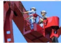
直轄点検(三島大橋)
