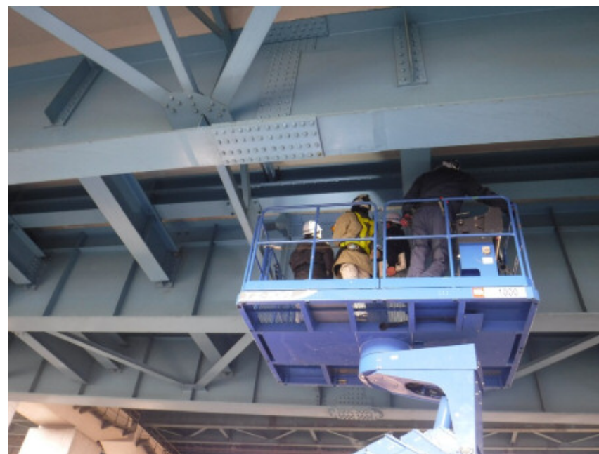
高所作業車を用いた近接目視点検
