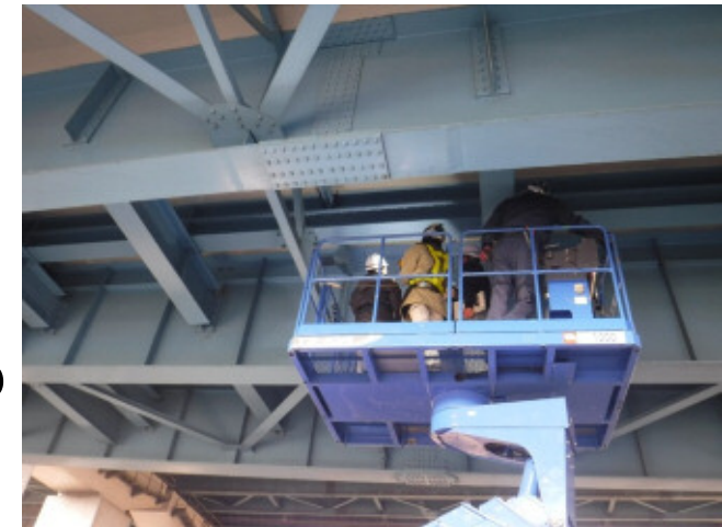
（橋梁研修等の実施状況）
