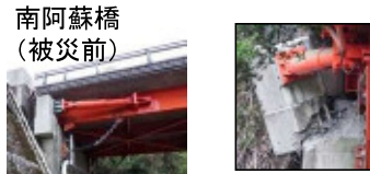
制震ダンパー取付部の損傷
