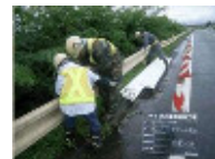
<防護柵の取替>
