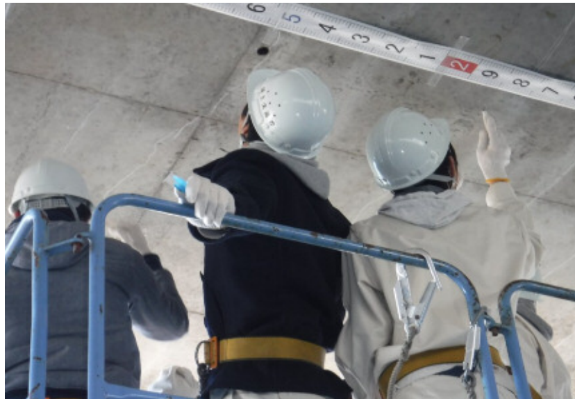
高所作業車を用いた近接目視点検
