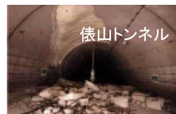
覆工コンクリートの崩落
