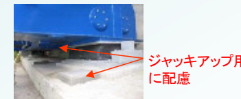
支保交換が容易な構造の例
