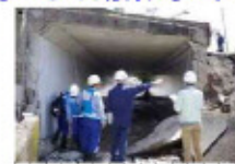
熊本特需における地方公共団体管理施設の被害状況調査
