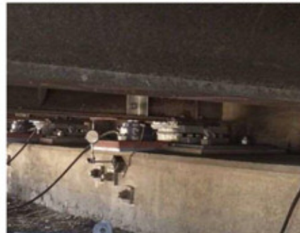
施工中(ジャッキアップ)
