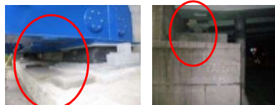
ジャッキアップに配慮した構造
