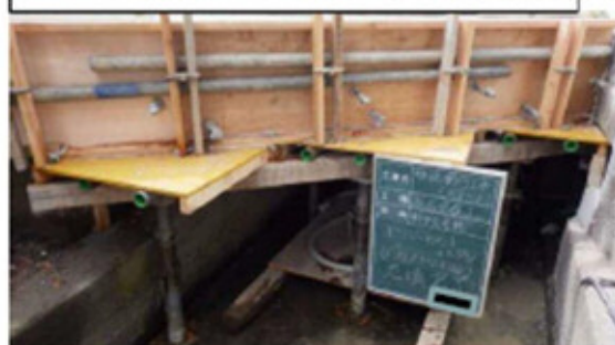
ポリマーセメントモルタル充填
