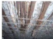
PC鋼材の腐食例
