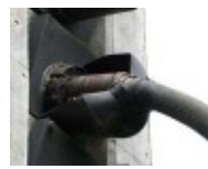
ケーブル損傷例
