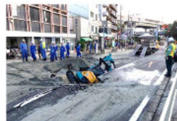
埋設管の老朽化に伴う道路陥没
