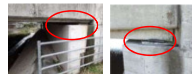
支承交換の作業空間なし
