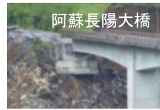
斜面変状による橋台の沈下
