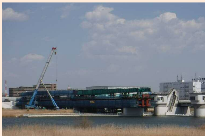
行徳橋架替工事(平成31年3月撮影)
