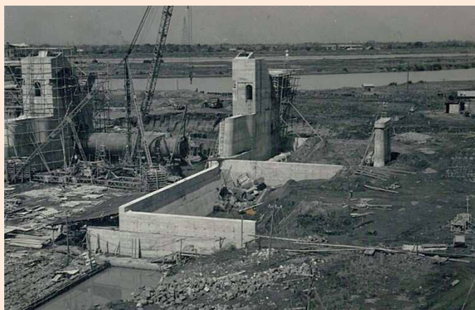
行徳可動堰建設工事(昭和29年9月撮影)
