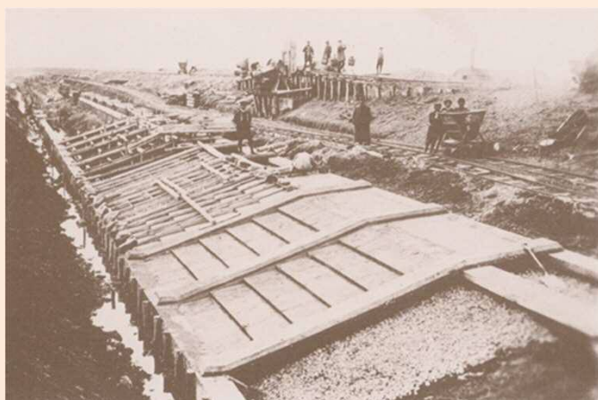
江戸川放水路護岸工事(大正10年1月撮影)
