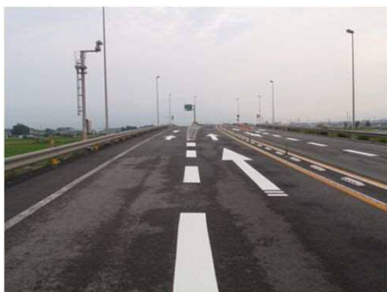
本線分流部 矢印路面標示
