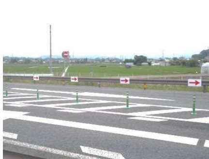
本線分流部 ラバーポール+矢印板
