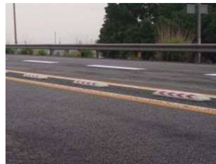
本線合流部 矢印板（樹脂ブロック部）
