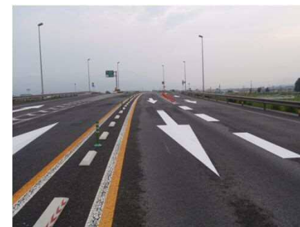
本線合流部 矢印路面標示
