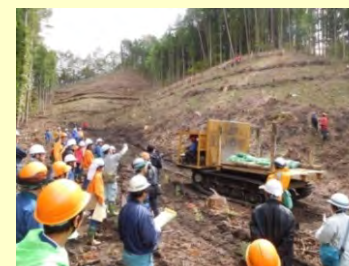
＜一貫作業システムの現地検討会＞
