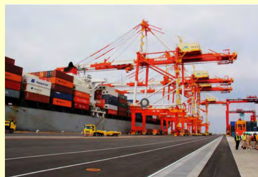
（出典）関東地方整備局HP
