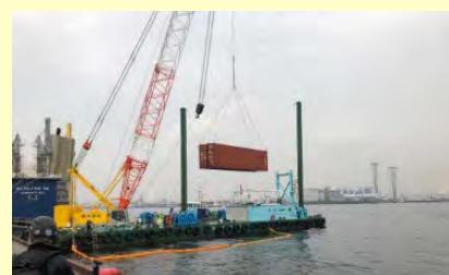
海底障害物の撤去
