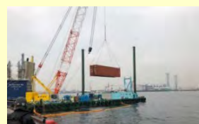
海底障害物の撤去
