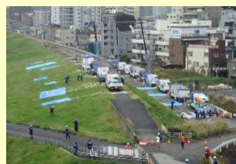
排水ポンプ車の設置
