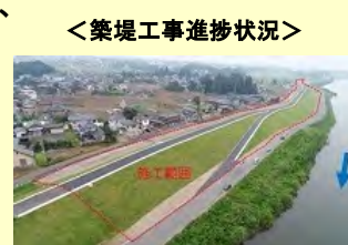
＜築堤工事進捗状況＞ (出典)関東地方整備局HP 鬼怒川右岸向右下築堤工事施工状況 (2018年7月20日時点)
