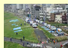
排水ポンプ車の設置
