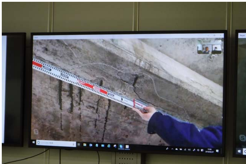
損傷状況のモニター表示
