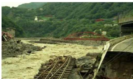
蒲原沢災害のきっかけとなった平成7年7月姫川災害 土砂流出により河床が10m上昇し各所で被害が出た
